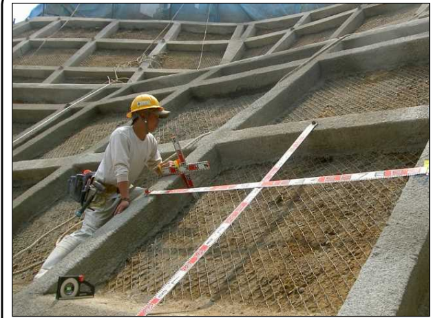
出来形計測・竣工検査
